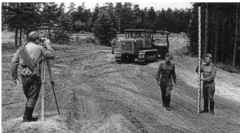
Нивелирование насыпи, 1979 г.
