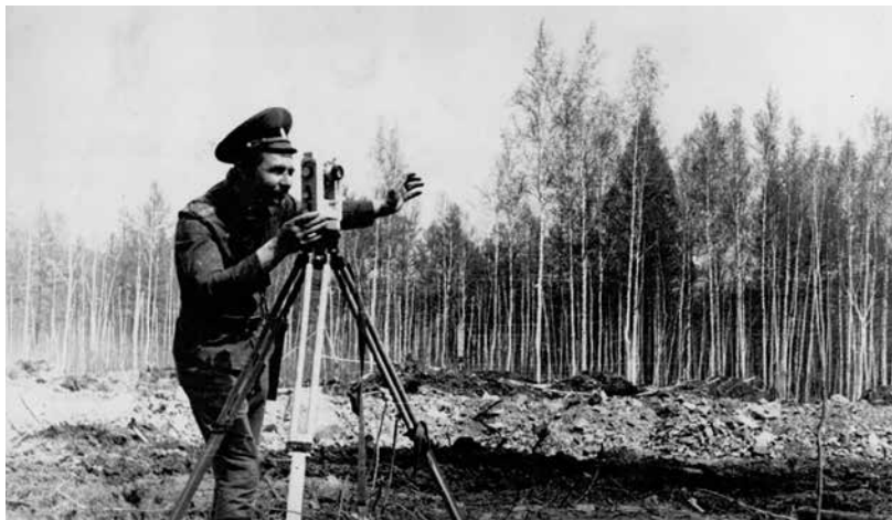
Геодезическую разбивку трассы ведет инженер-геодезист лейтенант А.И. Дрозд. Зейск. 1979 г.
