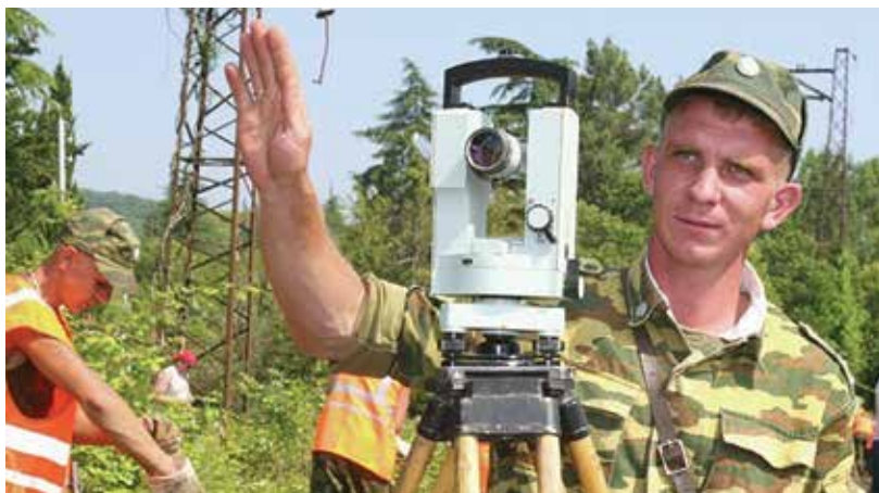
Строительство железной дороги в обход Украины 2015 г.
