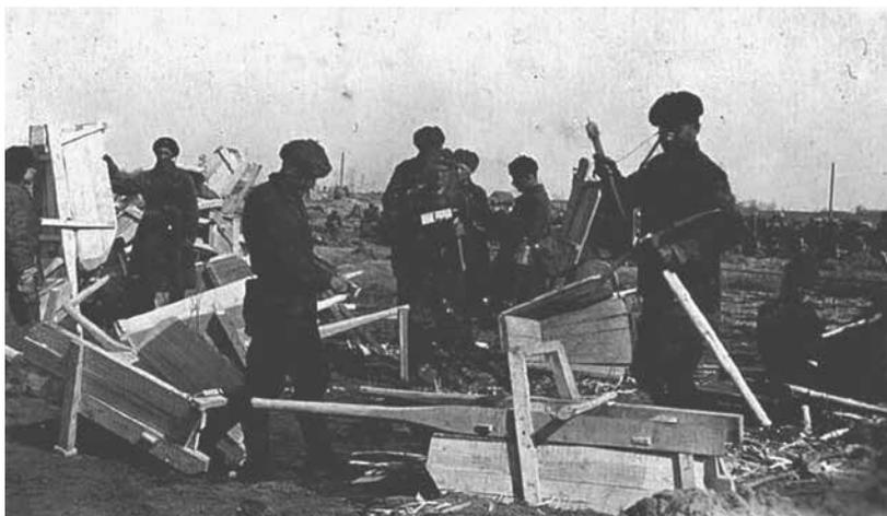
**Рис. 2. Изготовление тачек для перевозки грунта на строительстве Кобонского канала воинами-железнодорожниками 40 овждб**
