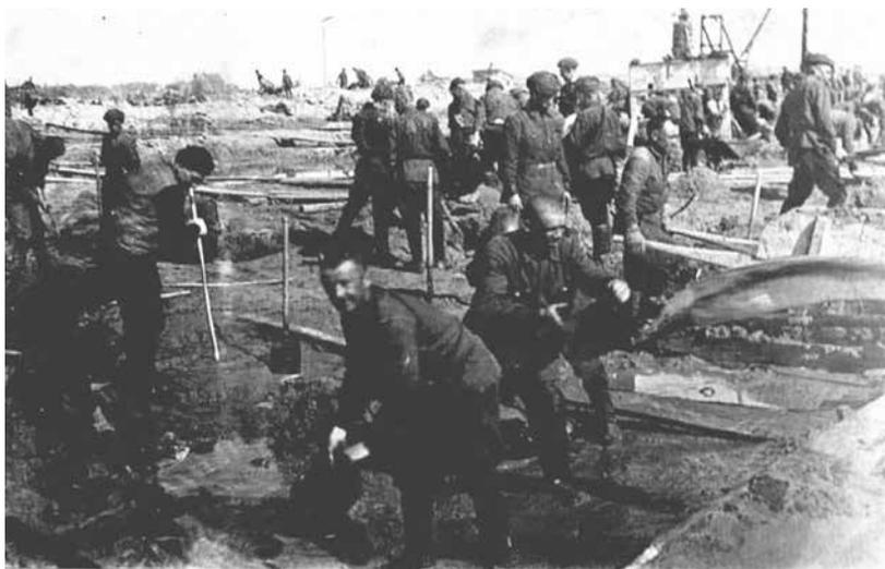
**Рис. 3. Выемка вручную грунта и перевозка в кавальеры воинами-железнодорожниками 22 омждб**
