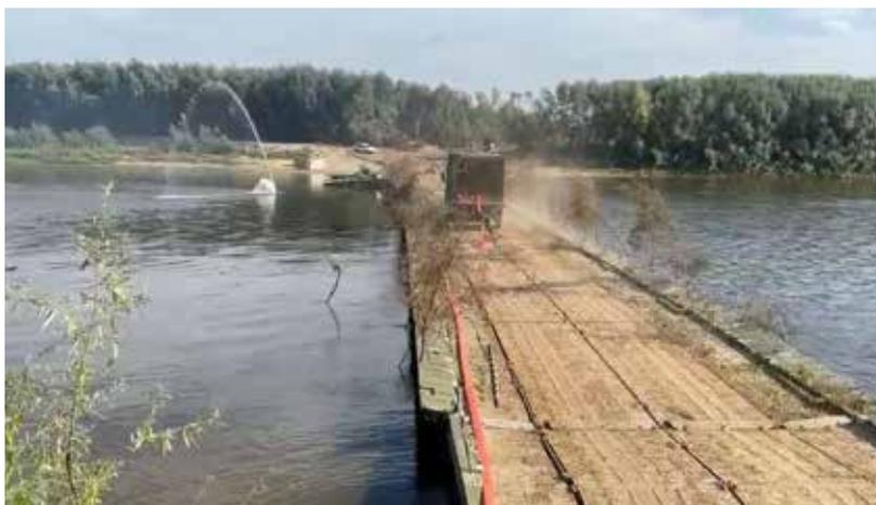
**Рис. 4. Отработка практических действий по развертыванию ПМКТ-100**
