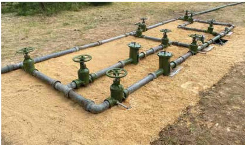
**Рис. 3. Контрольно-диспетчерский пункт трубопроводной роты**
