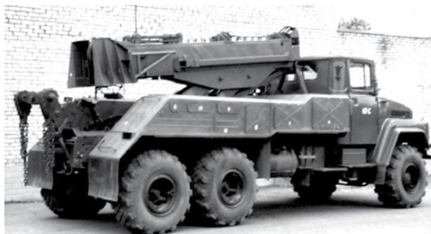
Рис. 18. Колесный эвакуационный тягач средний КЭТ-С (ТК 8А) на шасси КраЗ-260 (1992 г.)
